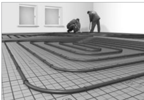
Подпольное отопление, выполненное мокрым методом - греющие трубы замоноличены в полу
